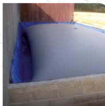
Rétention entre muret
